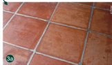
Traditional terracotta clay tiles used for floors. Jubin tanah liat digunakan untuk lantai. 紅方磚應用於地磚。
