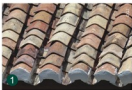
Terracotta clay U or V tile cover the roof and keep the buildings cool. Jubin Tanah Liat U atau V meliputi bumbung dan menjadikan bangunan sentiasa sejuk. 陶瓦 (U或V型) 鋪蓋的屋頂。
