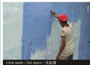
Lime wash / Cat kapur / 水灰漆
