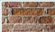
Brick wall with lime mortar / Dinding bata dengan mortar kapur / 磚牆用白灰砂漿黏合
