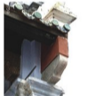
Corbel for small facade roof. Korbel untuk fasad bumbung kecil. 梁托用于正面前屋檐。
