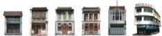
Stone is used in Early Penang to Art Deco style shophouses. Batu digunakan pada bangunan warisan dari era Early Penang ke Art Deco. 石材被應用於早期檳榔嶼式到藝術裝飾式的店屋中。
