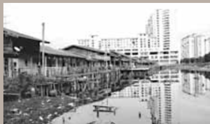
2005年被拆前的姓郭桥景观
